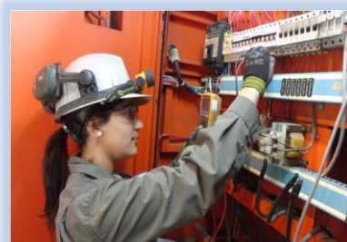
INSTALACIONES ELECTRICAS Y AUTOMATICAS
